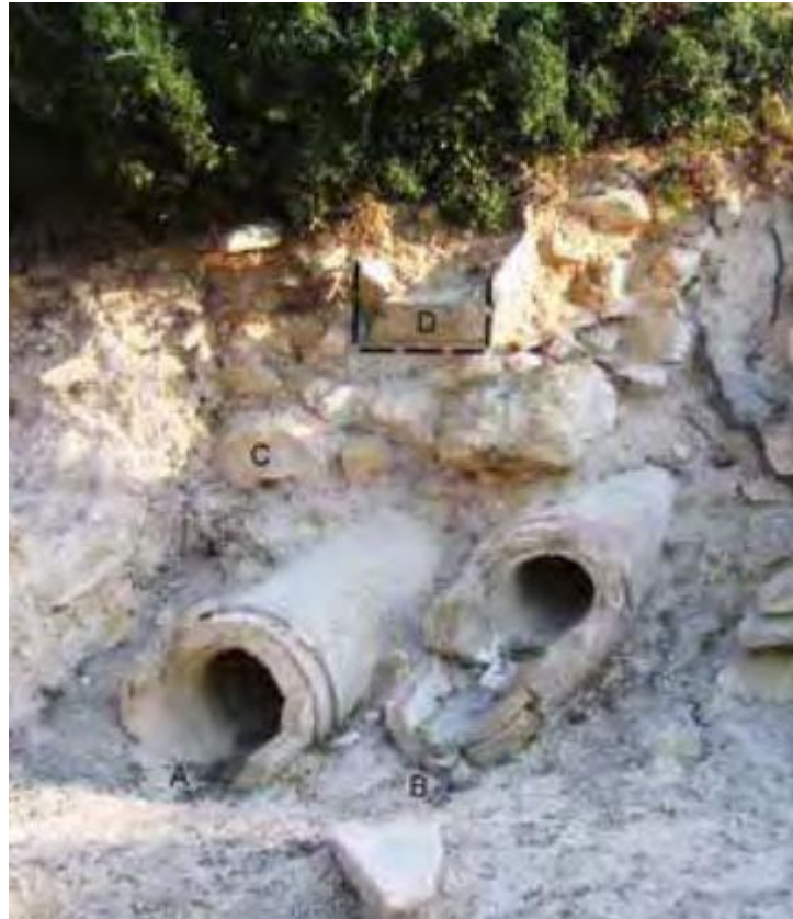
Figura 11. Detalle de canalización en paralelo del acueducto del noroeste, en Hierapolis Fuente: SCARDOZZI, G. 2020: 99.
